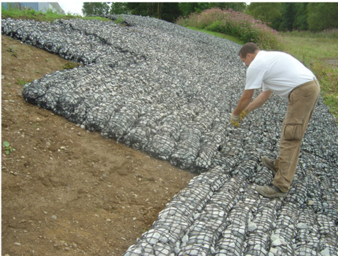
Die Elemente haben eine Größe von 2 m x 2 m und werden mit C-Ringen stabil miteinander verbunden.
