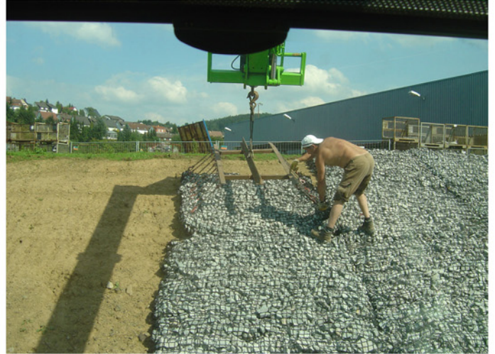
Verlegung mit Hilfe einer Traverse.
