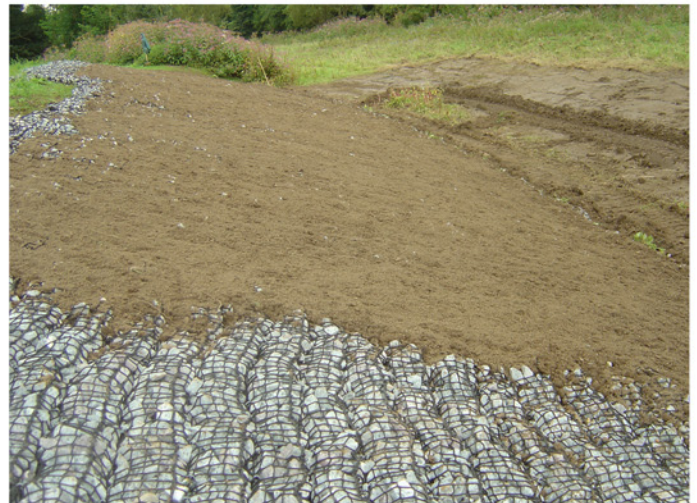
Nach der Verlegung werden die Steinmatratzen übererdet und angesät.
