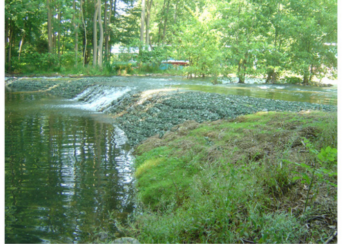
Im Sommer 2007 waren permanent hohe Wasserstände, so dass die Überlaufschwelle häufig überflutet wurde.
