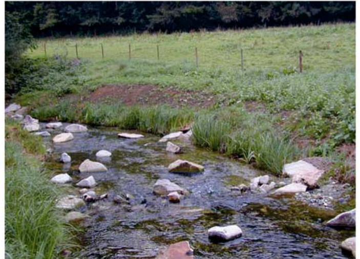
Auf dem rechten Ufer erkennt man die Röhrichtwalzen At the right bank you see the preplanted rolls
