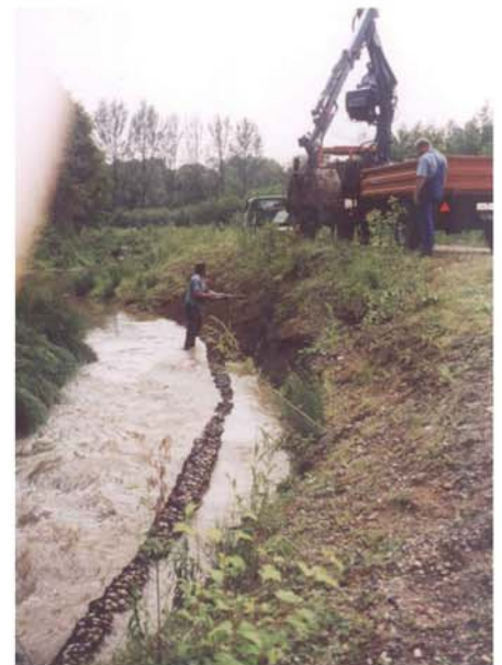
Am Böschungsfuß wird eine Steinwalze eingebaut. Installation of a rock-roll at the base of the bank.
