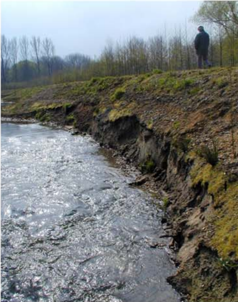
Uferabbrüche im Pralluferbereich Erosion at the embankment
