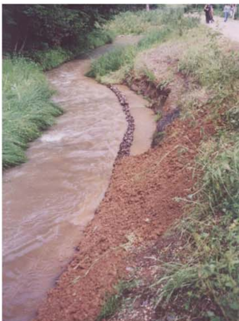
Neuaufbau der Böschung und Verfüllung mit Substrat Refilling of the slope with soil
